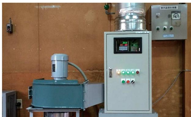
導入設備：LPガス小型温風発生機
