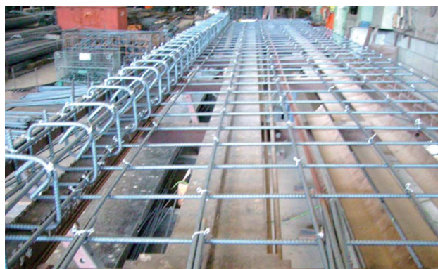
鉄筋加工組立例
