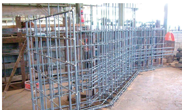
鉄筋加工組立例
