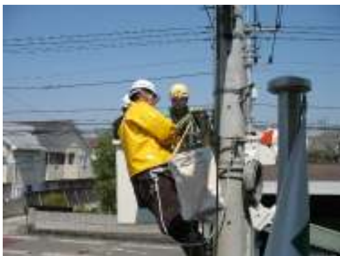
引込線工事実技訓練
