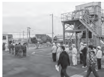
金磯南雨水ポンプ場
