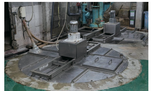
▲原料貯留槽の攪拌装置を取り替え、内部をステンレスに
