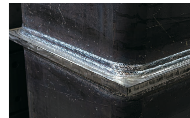
▲これまで手作業だった仕口溶接も自動化が図れた
