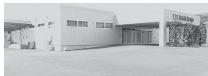
本社新工場外観
